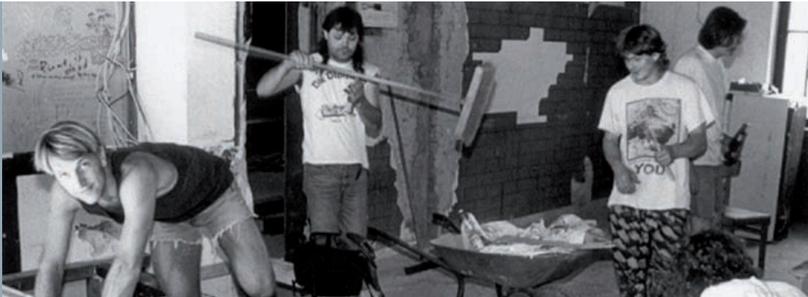
Village People für Arme: Gründer bei Renovierungsarbeiten 1991.
