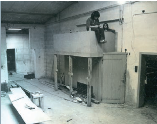
Bahndamm im Rohzustand: Disko (links) und Kneipenraum (rechts) 1981.
