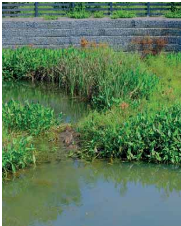
Abb. 21: Retentionsbecken mit Begrünung Quelle: dbvirago / stock.adobe.com
