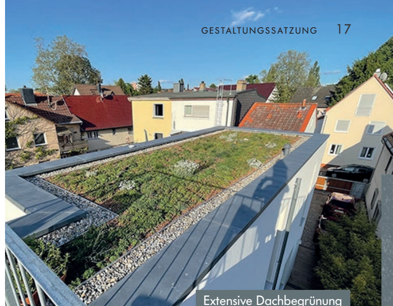
Extensive Dachbegrünung auf einem Flachdach
