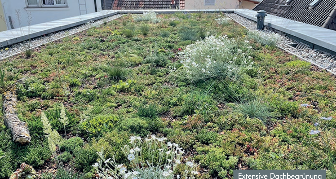
Extensive Dachbegrünung mit Kiesstreifen
