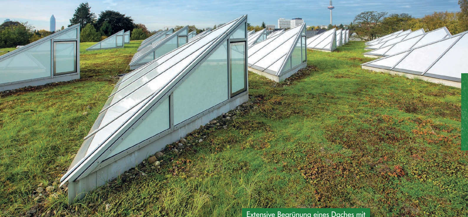
Extensive Begrünung eines Daches mit Lichtkuppeln in Frankfurt am Main
