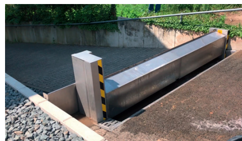
Abbildung 7 Mobiles Klappschott (Anhamm GmbH ( www.klappschott.de ))
