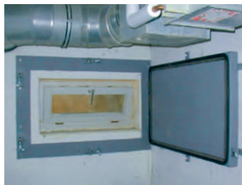
Abbildung 9 Druckdichtes, selbstschließendes Fenster (BMUB, 2016)
