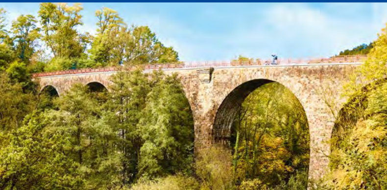
Viadukt Ruhrstraße, Heiligenhaus
