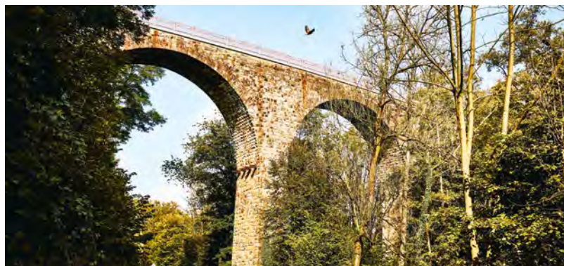
Viadukt Ruhrstraße, niederbergbahn
