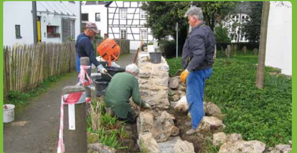
Mitglieder des Bürger- und Heimatvereins beim Bau der Mauer
